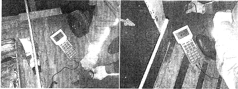
Рисунок 1, 2. Стальной трубопроводы речной воды в камере переключения ПВЗ-1
